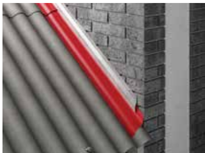
rys.45. Wykończenie styku połączenia dachowego ze ścianą.
